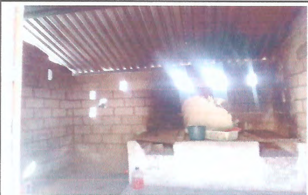
Foto 3: Reparación de área de cocina.
