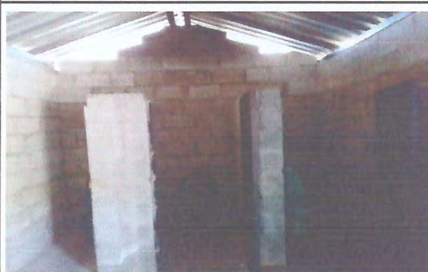
Foto 4: Mejoramiento de servicios sanitarios.
